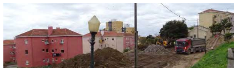
Obra em curso vai criar um espaço verde mais arborizado, zonas de tráfego mais seguras, mais acessibilidade e iluminação pública
