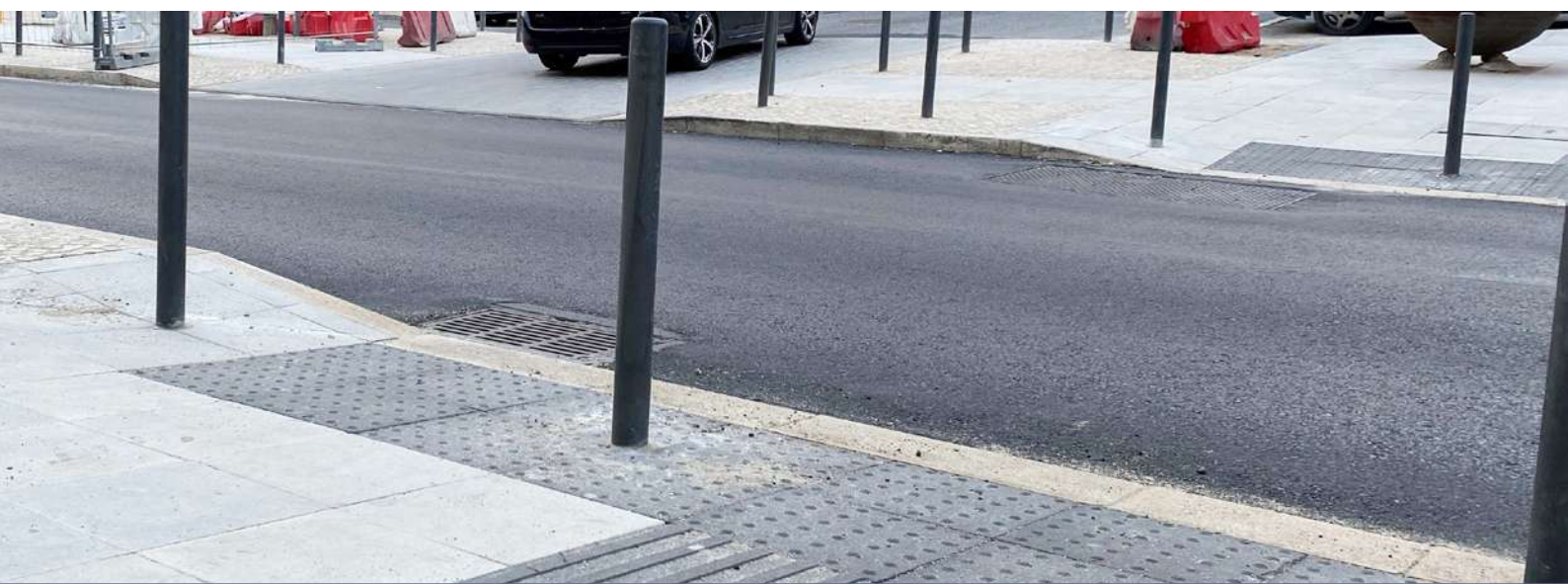
Pisos táteis, rebaixamento das calçadas e pavimentos antiderrapantes fundamentais para maior conforto e segurança dos peões
