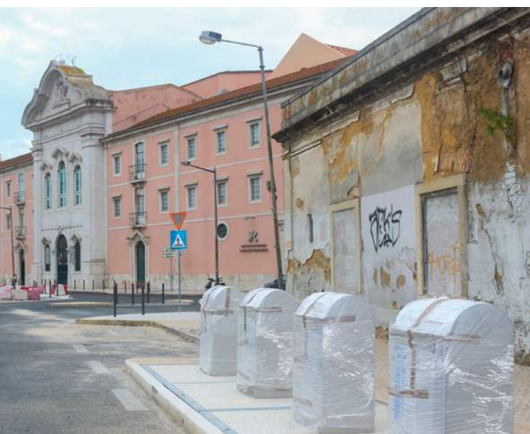
Além da renovação de pavimentos e abertura de novas vias, foi instalada mais uma ecoilha subterrânea na freguesia
