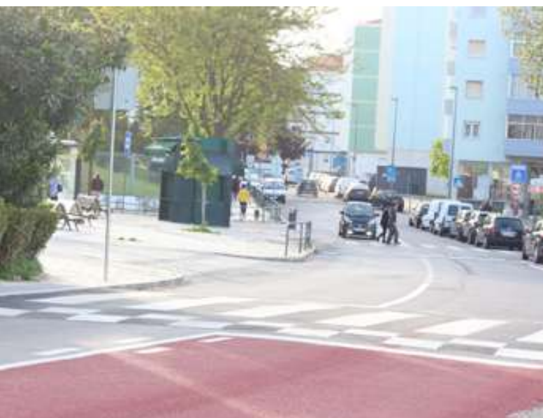
Piso diferenciado na aproximação às passadeiras para maior segurança de peões e automobilista
